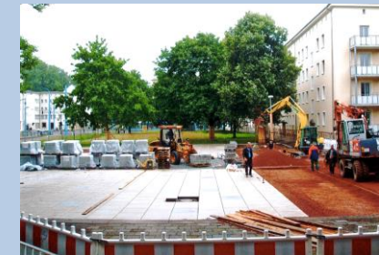
7. August 2012: Sanierung des Annenplatzes.
