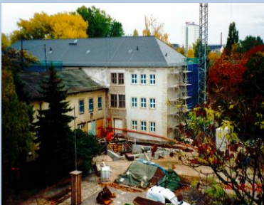
18.10.2000: Der Turmbau beginnt.
