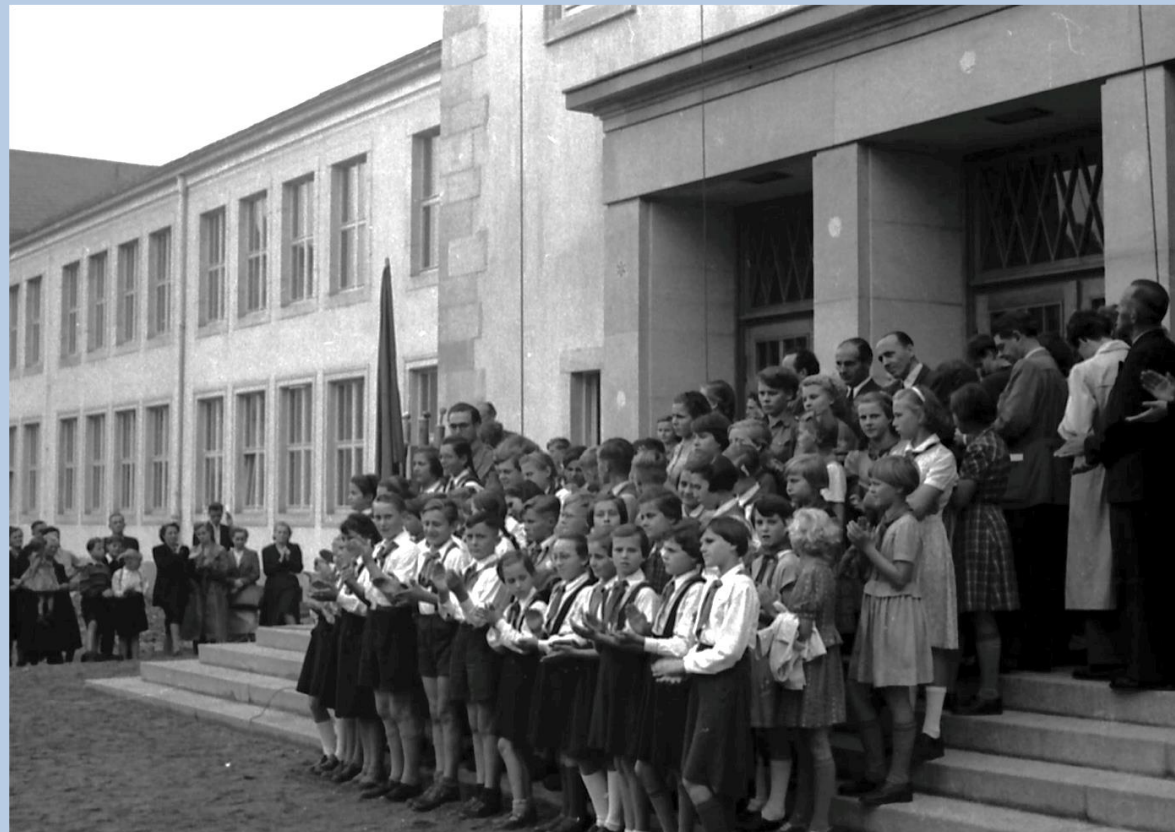
Einweihungsfeier des neu erbauten Schulgebäudes 1952.
