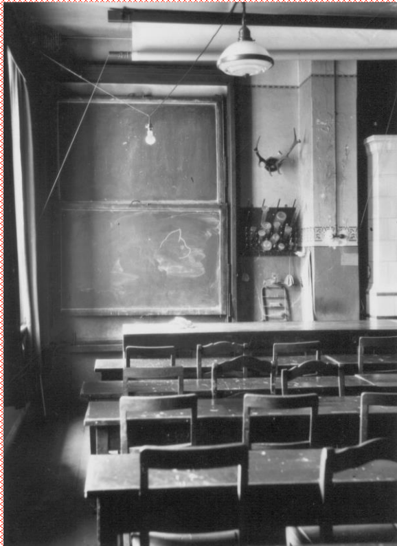
Unbefriedigende Situation: Innenansicht des Schulgebäudes Reitbahnstraße
