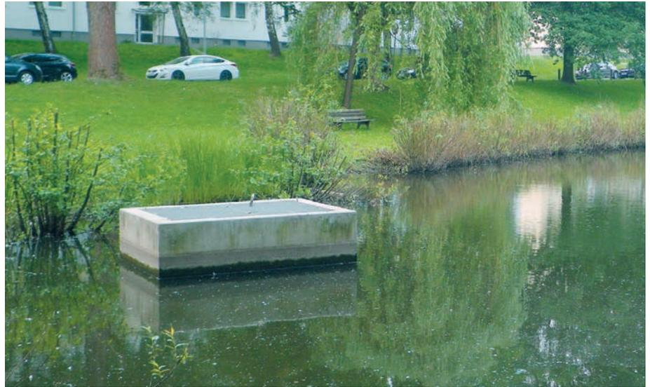
**Mönch.** Das Ablassen eines Teiches erfolgt über ein Ablaufbauwerk, welches der Regulierung des Wasserstandes dient. Es wird als Mönch bezeichnet. Foto: Ute Wetzel
