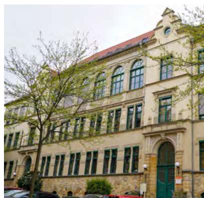
Das Evangelische Schulzentrum wurde durch Städtebaufördermittel saniert. Foto: Marie-Sophie Roß
