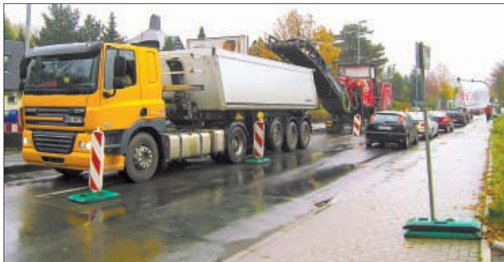
Kraftfahrer müssen beim Ausbau der Zschopauer Straße mit Verkehrsbehinderungen rechnen.
