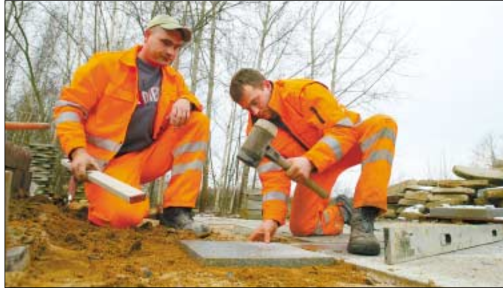
Wie man Platten fachmännisch verlegt, lernt Oliver Hammer von Lehrfacharbeiter Frank Koch (l.).
