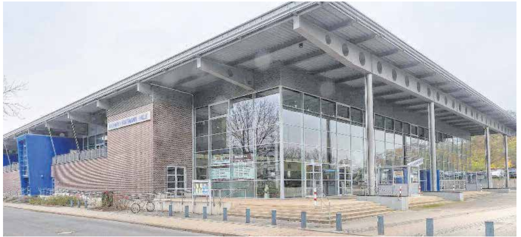
Der Bodenbelag der Richard-Hartmann-Halle wird nach einer jahrelangen intensiven Nutzung komplett erneuert. Die Bauarbeiten sollen innerhalb von drei Monaten abgeschlossen sein. Foto: Uwe Meinhold
