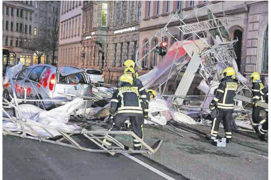
Am 18. Januar 2018 traf Sturmtief »Frederike« auf Chemnitz. Ein Baugerüst an der Theaterstraße stürzte um. Verletzt wurde zum Glück niemand. Zu rund 200 Einsätzen rückten die Chemnitzer Feuerwehren an diesem Tag aus. Foto: Haertelpress
