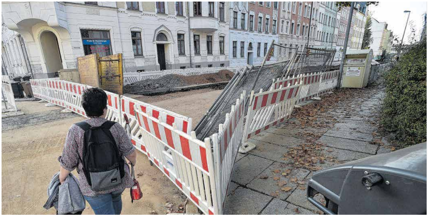
Umfangreiche Tiefbauarbeiten finden bis Ende 2020 in der Vetttersstraße statt.
