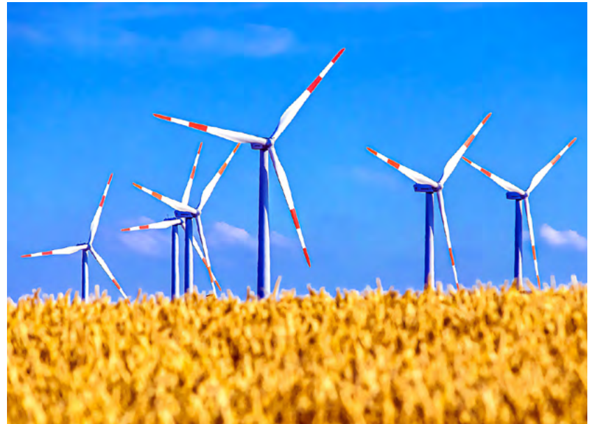
Am Galgenberg werden Windkraftanlagen gebaut.
