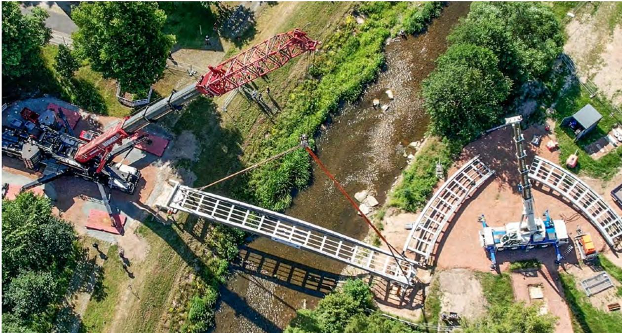
Es benötigt Millimeterarbeit beim Einhub der Brückenelemente, damit die neue Fußgängerbrücke im Flussbad Altchemnitz vollständig verbunden ist. Foto: Philipp Köhler
