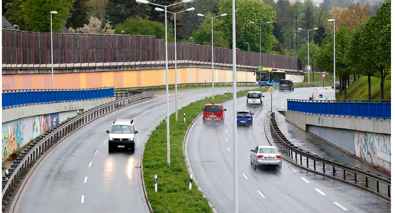
Auf dem Südring werden die Fahrbahnen erneuert.
