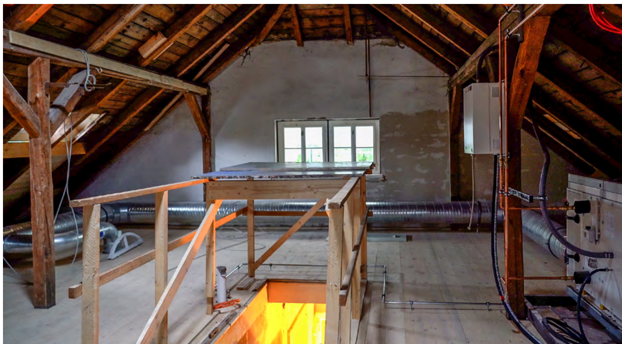
Das Karl Schmidt-Rottluff Haus ist eine der Interventionsflächen der Kulturhauptstadt Europas Chemnitz 2025. Wegen seiner kulturhistorischen Bedeutung werden das Haus und die Außenanlagen denkmalgerecht saniert. Foto: Marie-Sophie Roß
