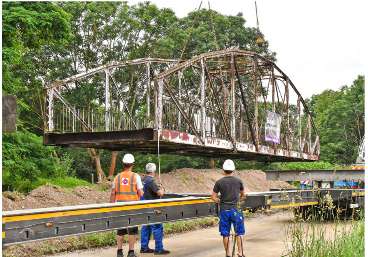
Die alte Fischwegbrücke bleibt als technisches Denkmal am Chemnitztalradweg erhalten.
