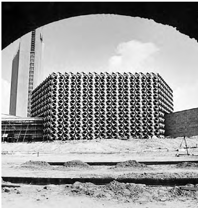
Im Bau: Die markante Außenfassade steht. Foto: C3 Chemnitzer Veranstaltungszentren GmbH
