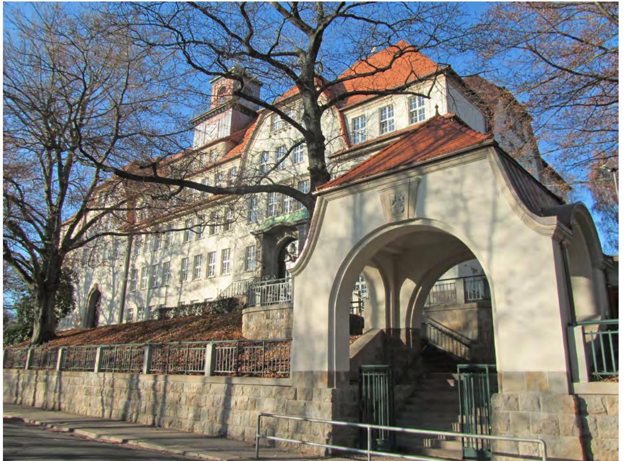
Die Schönauer Schule wird 2028 komplett saniert, aber im kommenden Jahr bereits barrierefrei gestaltet.
