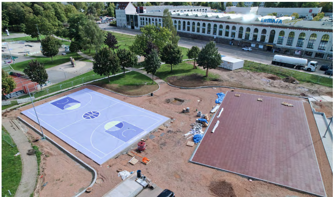
Das sanierte Spielfeld (links) hat bereits seinen markanten Vinylbelag bekommen. Der neue Basketballplatz nach FIBA-Vorgaben (rechts) ist als nächstes an der Reihe. Foto: Andre Zimpel
