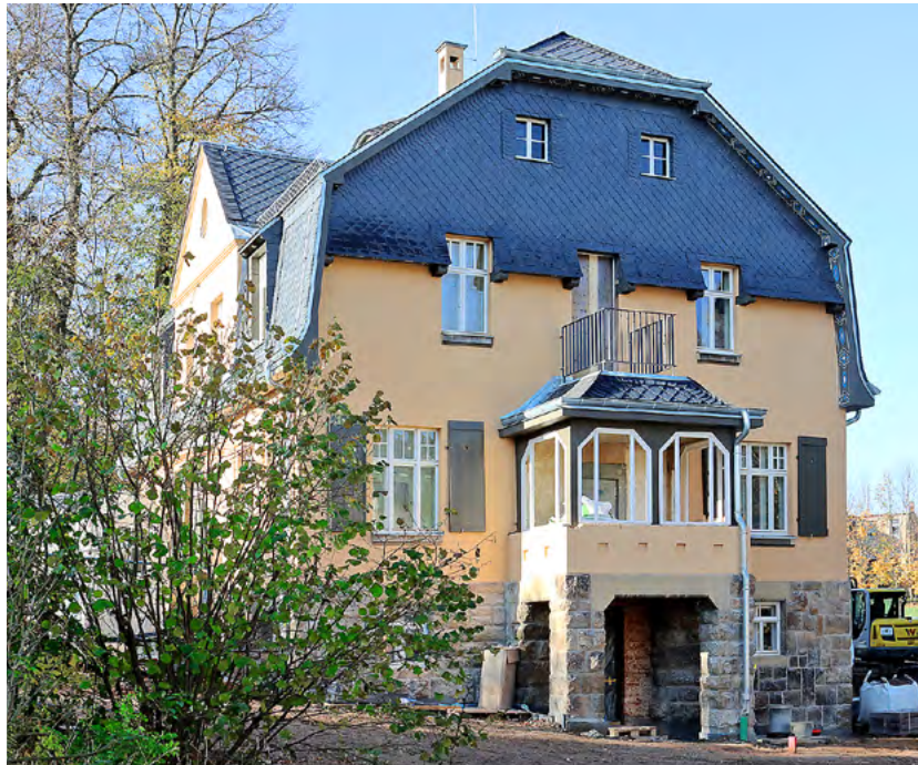
Mit der Sanierung des Karl Schmidt-Rottluff Hauses wird ein Stück Vergangenheit zum Leben erweckt. Foto: Franziska Wöllner
