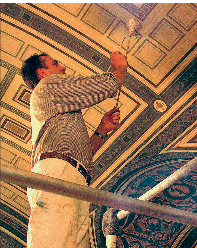
Die Deckenmalerei in der Wandelhalle des Neuen Rathauses wird gegenwärtig einer Teilrestaurierung unterzogen. Damit sollen Risse und Wasserschäden behoben werden. Besonderes handwerkliches Geschick verlangt dabei die Abstimmung zwischen älteren und frisch aufgetragenen Farben. Der erfahrene Chemnitzer Restaurator Georg Richert – der bereits eine umfassende Restaurierung der Halle in den 80er Jahren ebenso wie die des Ratskellers geleitet hatte – betreut diese diffizile Aufgabe, welche die Firma Maler Süd GmbH übernommen hat. Malermeister Stephan Bauermeister (Foto) ist einer von vier Handwerkern, die mit dieser anspruchsvollen Arbeit betraut wurden. Die Wandelhalle ist ein besonders repräsentativer Saal im denkmalgeschützten Neuen Rathaus, das 1911 nach vierjähriger Bauzeit seiner Bestimmung übergeben wurde. Zuvor wurde besagte Halle mit Deckenornamenten sowie zahlreichen, in plastischen Rahmen gefassten Bildern verziert, welche öffentliche Verwaltungsbereiche wie Theater, Schule, Museen und Finanzen symbolisieren. Die Wand- und Deckenmotive, die mit Kaseinfarbe aufgebracht sind, stammen vom Dresdner Maler Paul Perks. Georg Richert restaurierte 1974/75 übrigens nicht nur sichtbare Ornamente, sondern gestaltete außerdem Wandmalereien, die in den 60er Jahren überflücht worden waren, anhand alter Vorlagen und Fotografien nach. Die derzeitige Auffrischung der Fresken ist Teil einer größeren Baumaßnahme im so genannten Weberflügel des Rathauses, in deren Verlauf auch die Heizungsanlage sowie Elt- und Telefonleitungen unter Berücksichtigung denkmalpflegerischer Belange erneuert werden. ● (eh) Foto: Ehrenberg
