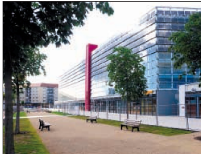
Die Wallanlage ist fertig.
