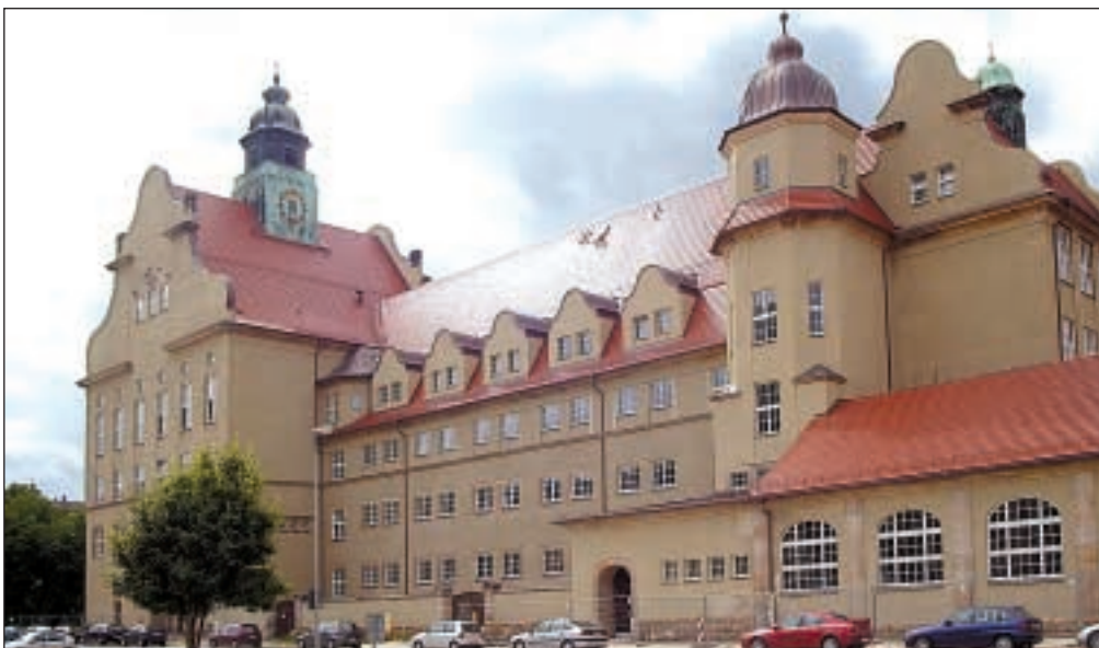
Saniertes Schulgebäude an der Schloßstraße.
