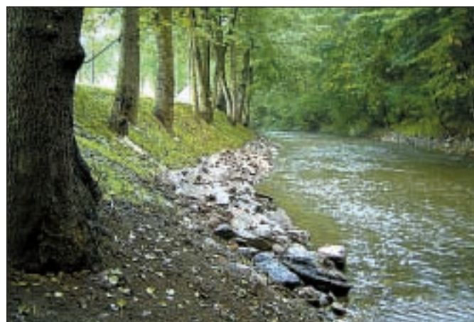
Hochwasserschadensbeseitigung durch die Landestalsperrenverwaltung: Uferbefestigung an der Zwönitz im Bereich Sportplatz Einsiedel.
