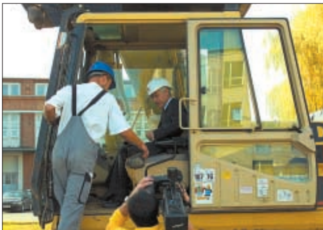
Erster „Spatenstich“ für den Neubau der MLG Motoren-Logistik. Foto: Schmidt
