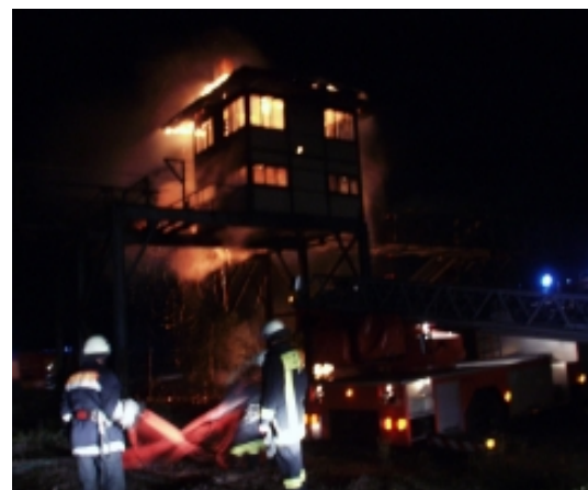
Brand altes Stellwerk an der Glösaer Straße
