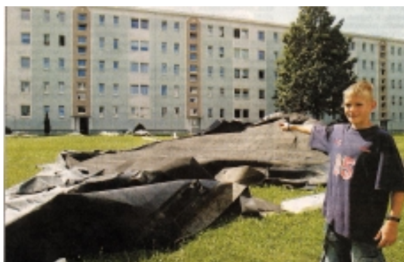
Abgedecktes Dach L.-Ebersberger-Str.
