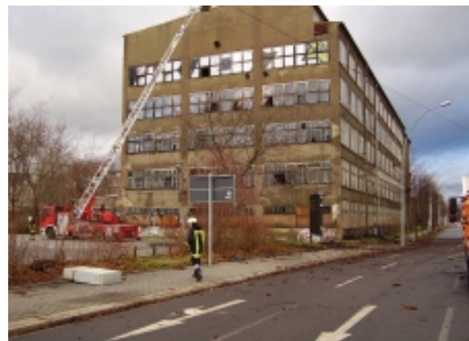
abgedecktes Dach an der Annaberger Straße
