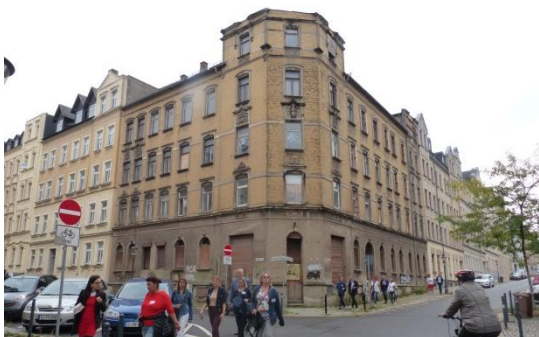
Im Fokus von ALT/BAU: leerstehende gründerzeitliche Gebäude Foto: Agentur StadtWohnen
