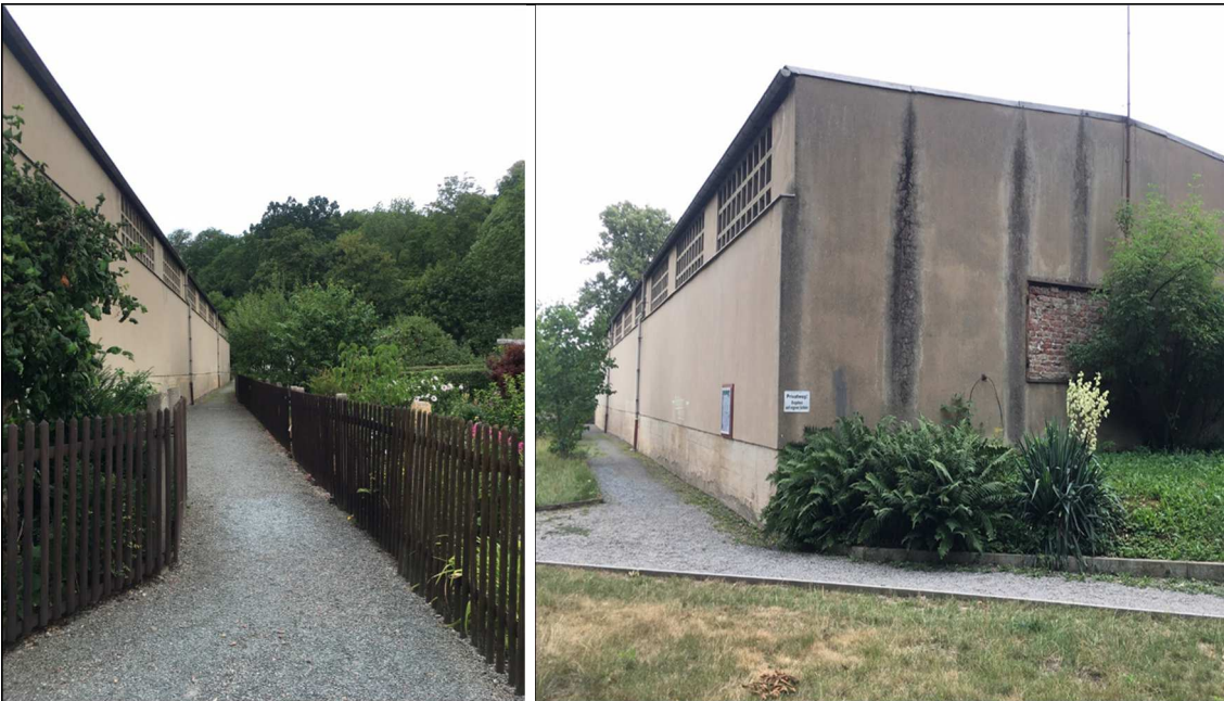
Abbildungen 7/8: Rückseite der Halle aus Richtung Kleingartenanlage und Fußweg gesehen
