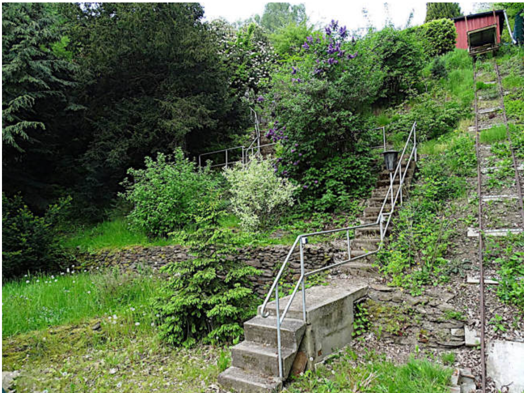
Bild 7: Trockenmauern am Hang im westlichen Teil des Plangebiets
