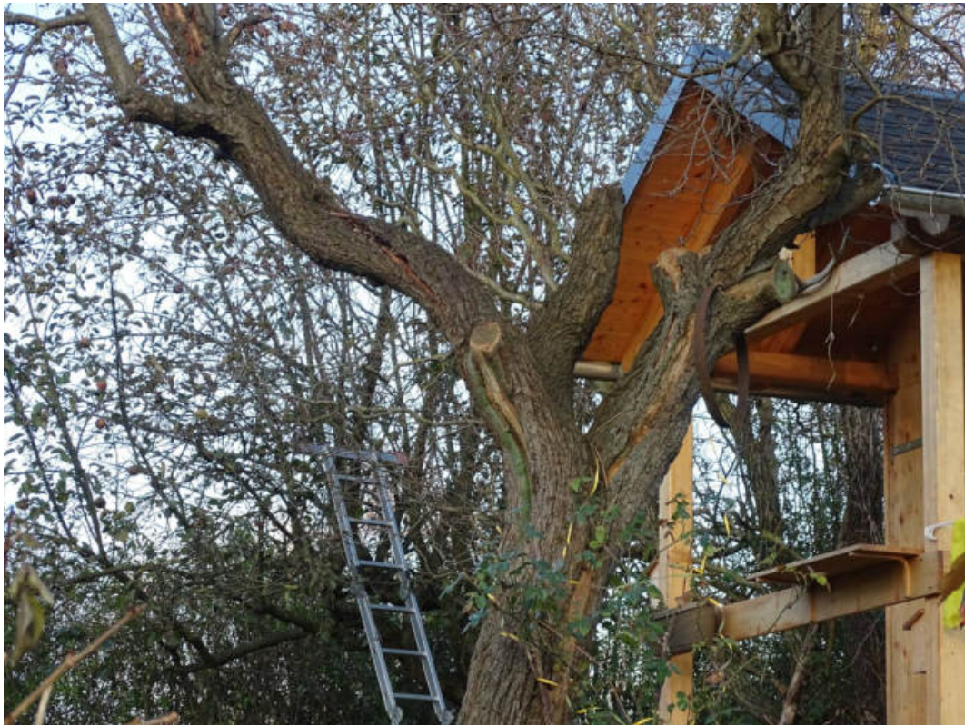
Bild 30: Pflaumenbaum Nr. 18 mit Spalten im Stamm
