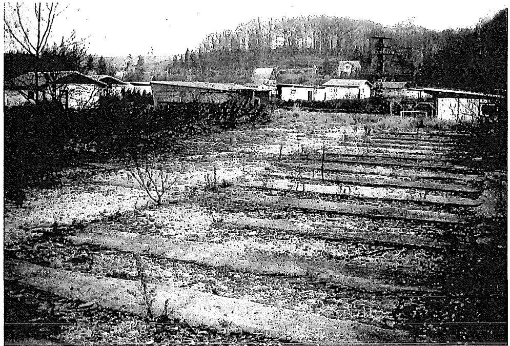
Bild 3 Fundamentplatte eines Gebäudes der ehem. Färberei an der Flußbiegung
