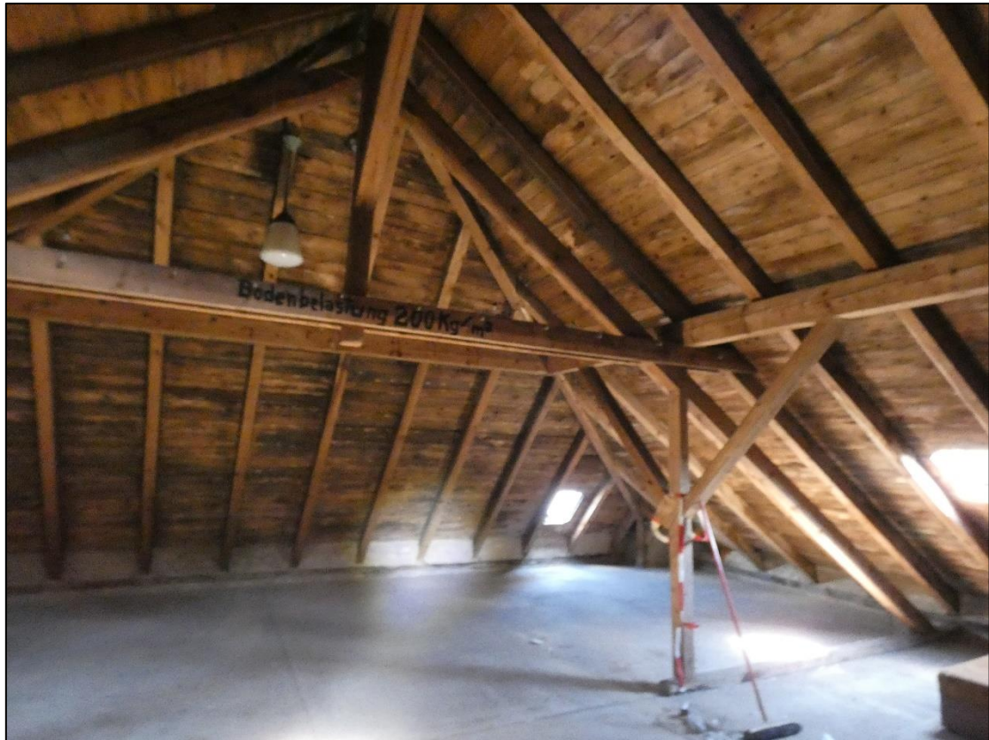
Abb. 5: Dachboden im südlichen Teil von BW3
