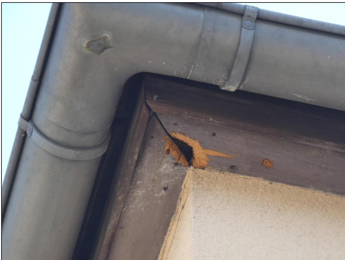
Abb. 4: Einflug-Spalt (2x) am nördlichen Giebel von BW3
