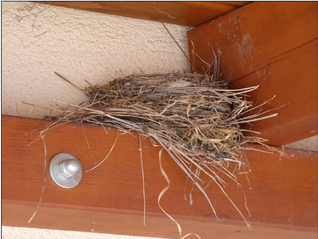
Abb. 7: Nest unter Überdachung an BW3
