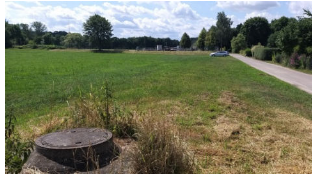
Abbildung 4: Regenüberlaufbecken mit Abwasserpumpwerk
