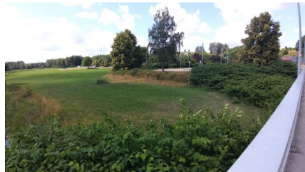
Abbildung 33: Überflutungsflächen, rechts Bushaltestelle
