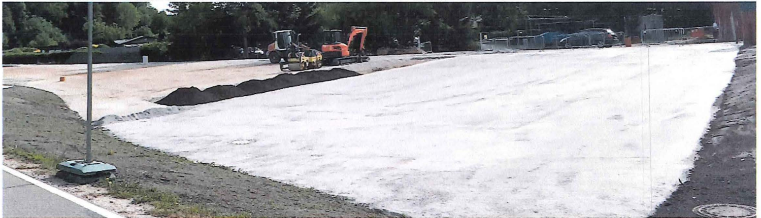
Aktueller Bauzustand 6/2022 mit fertiger Parkplatzfläche
