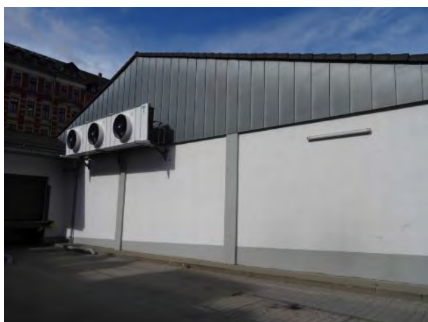
Foto 5: Ostseite des Gebäudes mit lückenlos verkleidetem Giebel, ohne Nischen und Spalten
