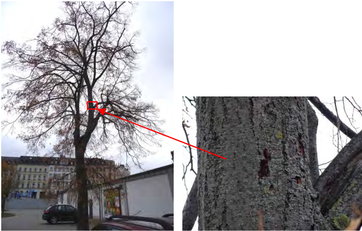
Foto 5, 6: An der W-Seite weist der Stamm Schäden in der Rinde auf, vermutlich vom Specht beim Versuch Höhlen anzulegen
